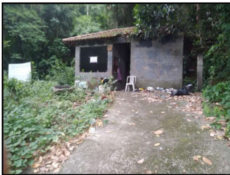
IMÓVEL PRÓPRIO DO PARNA TIJUCA SETOR D SERRA DOS PRETOS FORROS EM ESTADO DE ABANDONO AO LADO DO HOSPITAL CARDOSO FONTES COM CARATERÍSTICA DE INVASÃO, OCUPAÇÃO IRREGULAR
