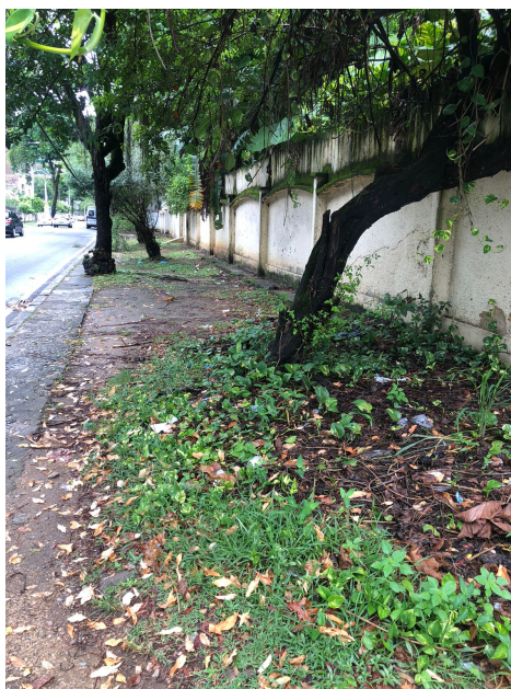
06/04/2023: calçada com estado ruim para passagem de cadeirante
