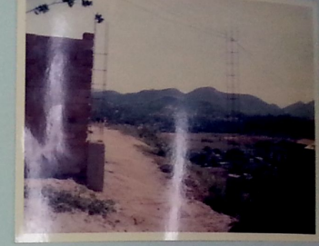
1997 - Setor 01 - Colocação do Muro do Monte de Oração
