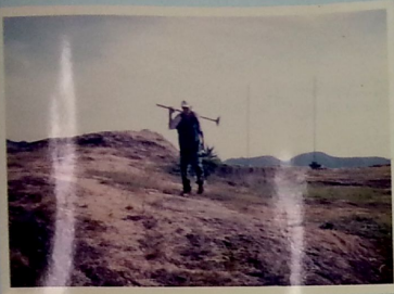
1997 - Setor 01 - Monte de Oração - início da colocação do Muro do Monte de Oração
