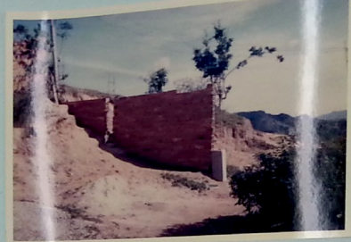
1997 - Setor 01 - Colocação do Muro do Monte de Oração
