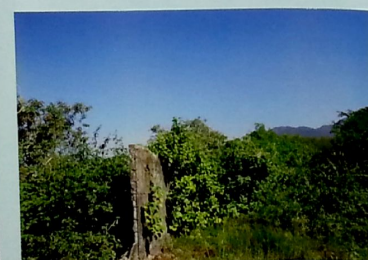
2015 - Setores 05 e 09 - Divisa com o muro da empresa P&G, parte alta
